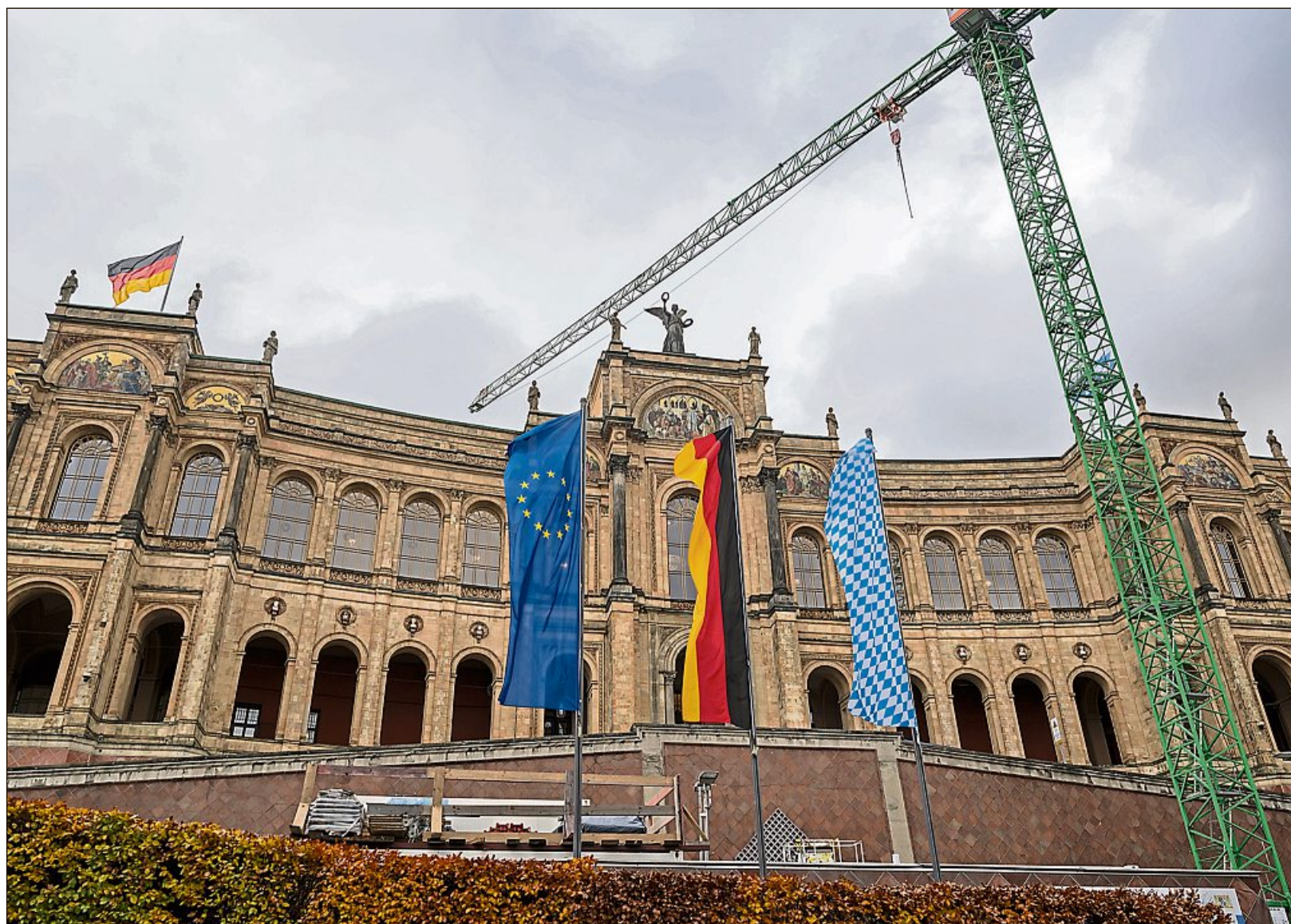
Der Außenbereich des Landtags ist noch länger eine Baustelle. Innen kann es aber jetzt mit der Sachpolitik in den Ausschüssen losgehen. FOTO: DPA/KNEFFEL
